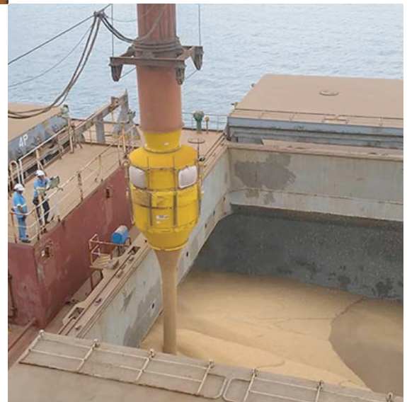
Figura 10: Supressor de pó tipo DSH utilizado no carregamento de graneis sólidos.
