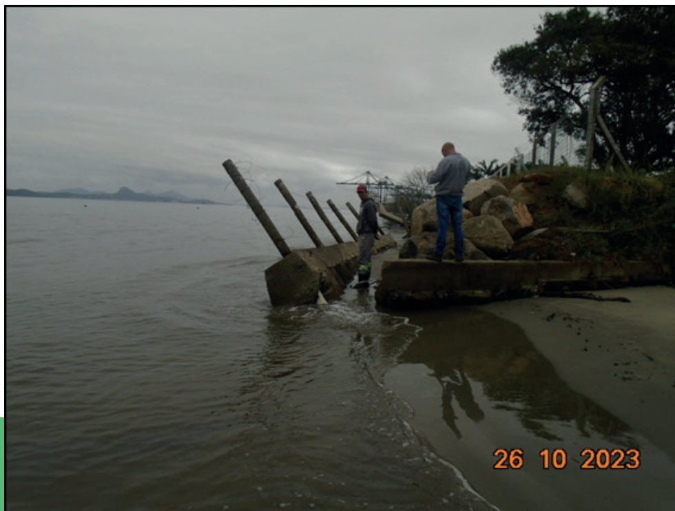
Figura 48: Erosão costeira causando danos à infraestrutura (costa em frente AI).
