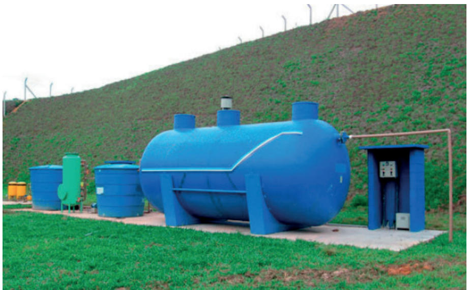
Figura 26: Exemplo de estação compacta de tratamento de efluentes
